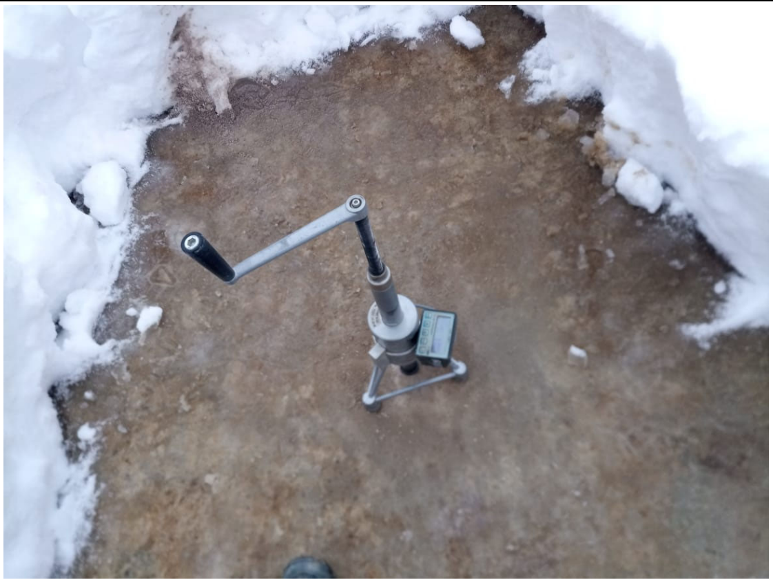
Рис. 4.2.4. Установка прибора ПОС 50МГ-4 для проведения испытания в монолитной железобетонной фундаментной плите в осях 2/1-2/3/А-А/1
