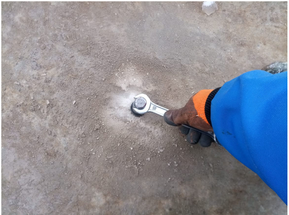
Рис. 4.2.3. Установка анкерного устройства и тяги в отверстии монолитной железобетонной фундаментной плиты в осях 2/1-2/3/А-А/1
