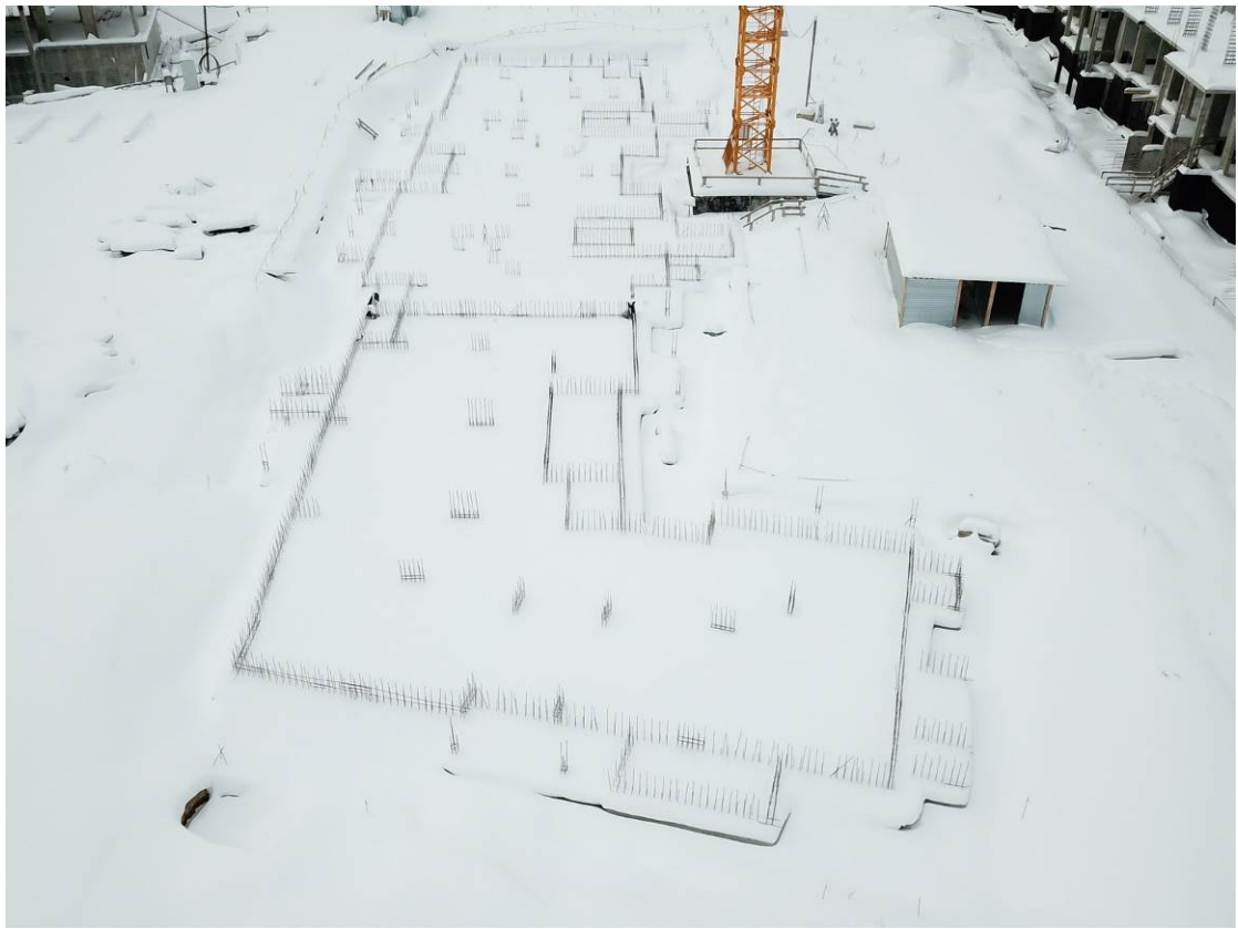
Рис. 1.1. Общий вид фундаментной плиты жилого дома 27 корпус 2 в осях А/2-Б/ 4
