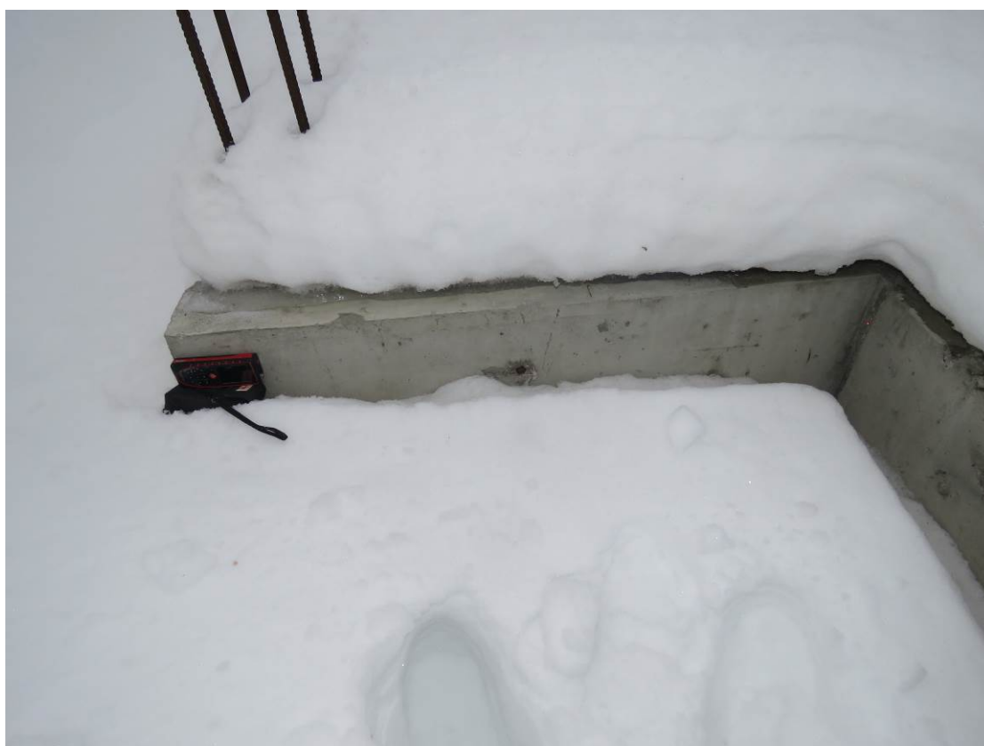
Рис. 2.2. Замер габаритных размеров фундаментной плиты при помощи лазерного дальномера
