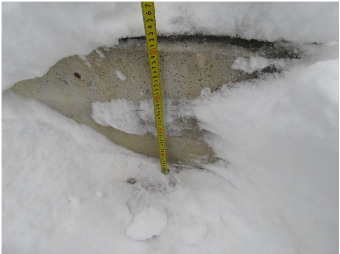
Рис. 3.1.2. Уточнение сечения фундаментной плиты секции 1 ( 400 мм)
