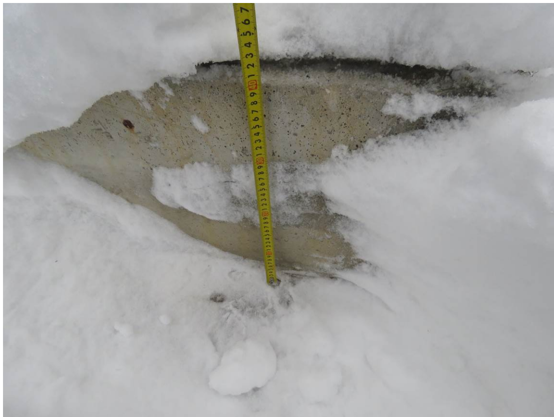
Рис. 2.1. Уточнение сечения фундаментной плиты секции 2
