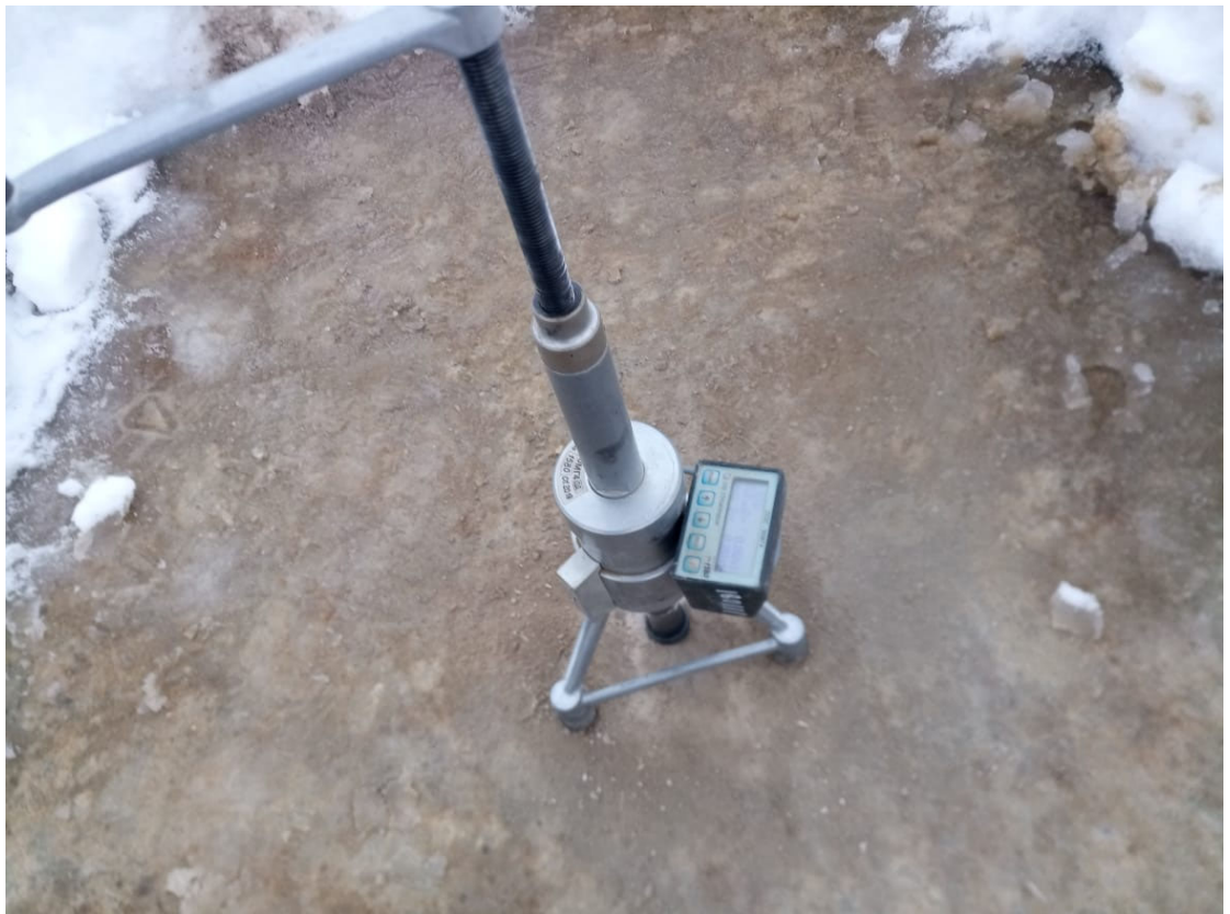
Рис. 4.2.5. Испытание бетона монолитной железобетонной фундаментной плиты в осях 2/1-2/3/А-А/1 методом отрыва со скалыванием прибором ПОС 50МГ-4
