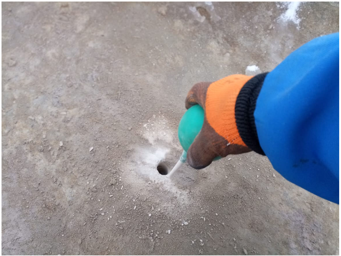
Рис. 4.2.2 . Продувка отверстия от пыли в монолитной железобетонной фундаментной плите в осях 2/1-2/3/А-А/1
