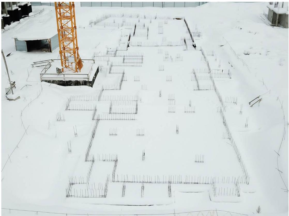
Рис. 1.2. Общий вид фундаментной плиты жилого дома 27 корпус 2 в осях А/11-А/1
