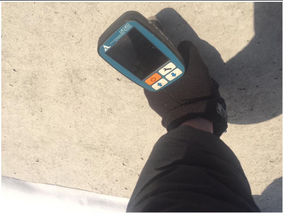
Рис. 4.3.1. Определение прочности бетона в монолитной железобетонной фундаментной плите ультразвуковым методом прибором UK 1401
