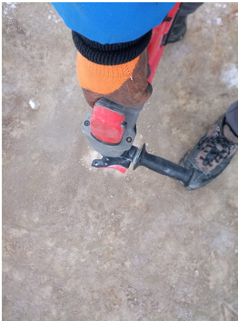
Рис. 4.2.1. Сверление отверстия в монолитной железобетонной фундаментной плите в осях 2/1-2/3/А-А/1
