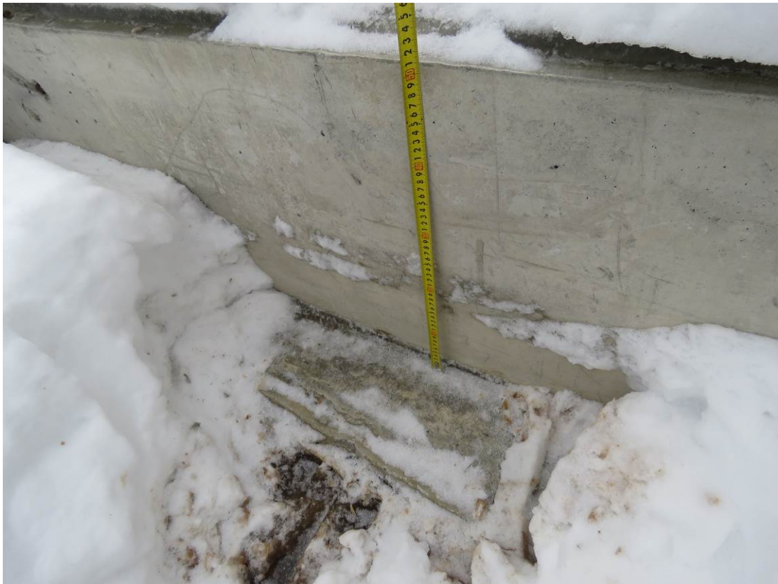
Рис. 3.1.4. Уточнение сечения фундаментной плиты секции 3 ( 500 мм)
